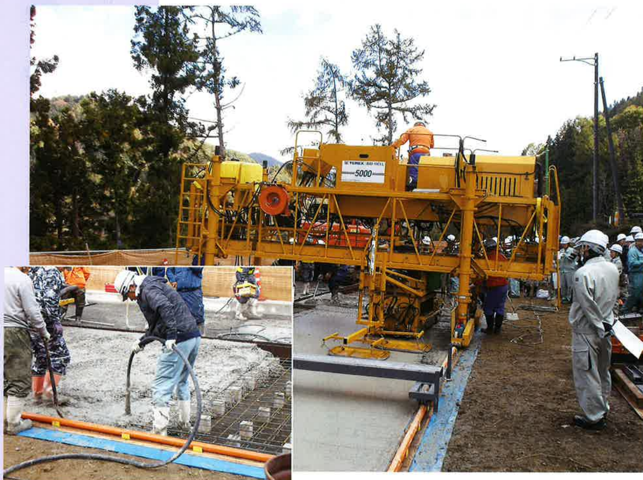
—コンクリート舗装工事(西組BP)—
